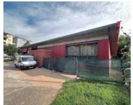
14-06-2024 Arranjament Caseta Vermella.
