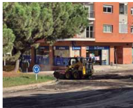
09-11-2024 Asfaltatge rotonda de Pericot.
