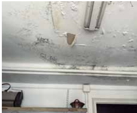
27-06-2024 Reparació de filtracions al Local Vell.
