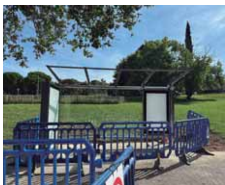
15-09-2025 Parada en construcció de l'L9 BRcat a Montilivi.
