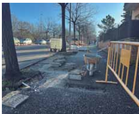
3-02-2026 Reparació de la vorera del carrer Puigsacalm.
